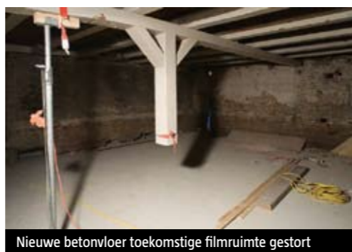
Werkvoer oude spaarbogenvundering gestort
